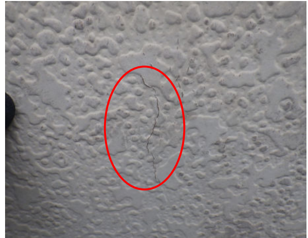
【外周り】 劣化等の箇所 2 外壁面に小さなひび割れがところどころありました。この写真は代表的な写真です。塗装の劣化も見受けられますので、そろそろ外壁塗装メンテナンスをおすすめいたします。
