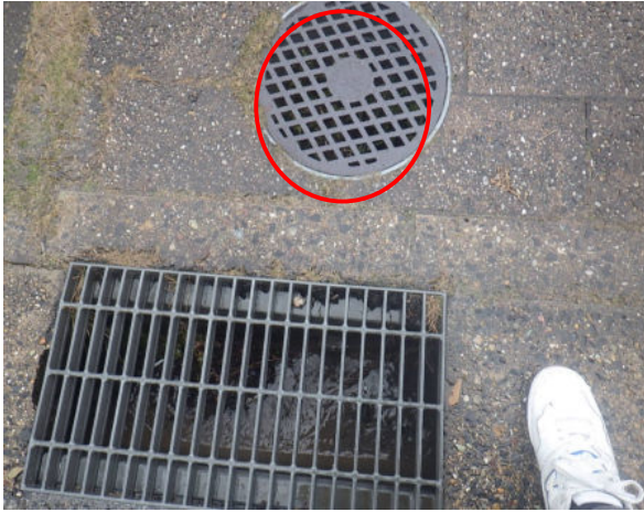
【外周り】 劣化等の箇所 1 雨水最終マス内部に、側溝から雑草が侵入し、生い茂っていました。排水管が詰まる要因となります。内部の清掃をお勧めします。
