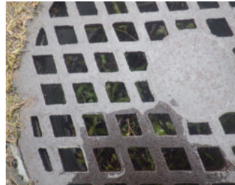
【外周り】 劣化等の箇所 1 雨水最終マス内部に、側溝から雑草が侵入し、生い茂っていました。排水管が詰まる要因となります。内部の清掃をお勧めします。
