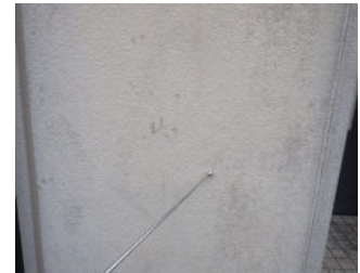
【外周り】 劣化等の箇所 2 外壁面に小さなひび割れがところどころありました。この写真は代表的な写真です。塗装の劣化も見受けられますので、そろそろ外壁塗装メンテナンスをおすすめいたします。
